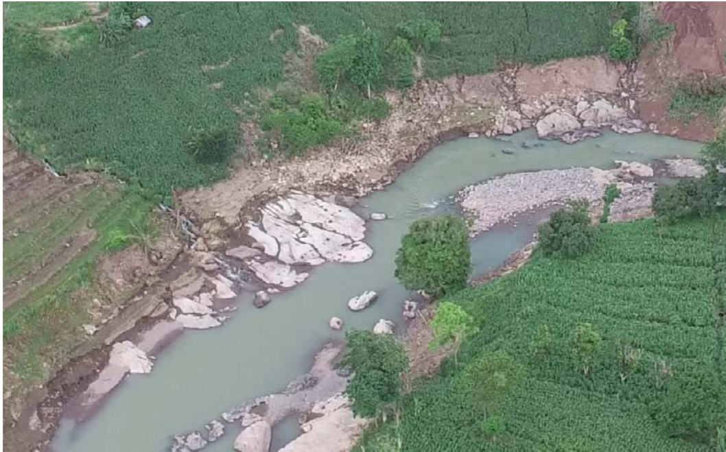
Gambar 7. Kondisi Pengikisan pada Tebing Sungai Kelara
